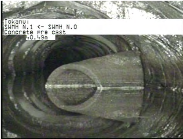
MH N.0 To MH N.1_9ae4f51b-189a-4bab-be16-10cb53b7fe75_20230406_16 0413_898.jpg, 00:11:22, 40.49m
