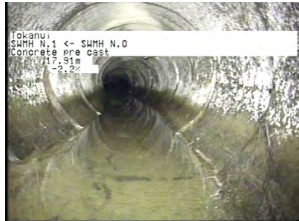
MH N.0 To MH N.1_3eac6d58-c56f-4066-8242-dc9fa803d092_20230406_155620_357.jpg, 00:04:59, 17.91m
