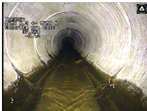
MH N.1 To MH N.2_df2cdf52-89b8-443e-a250-bfb9ad9ce134_20230424_095 759_488.jpg, 00:10:47, 37.66m
