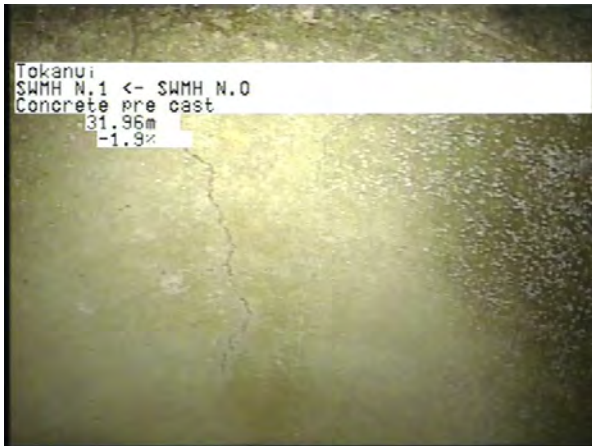
MH N.0 To MH N.1_30d3853e-2439-4199-8db5-d60147d27aa8_20230406_160002_120.jpg, 00:07:54, 31.96m
