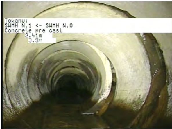
MH N.0 To MH N.1_259abef6-3357-417a-b6b1-21ff3703d394_20230406_154853_590.jpg, 00:18:55, 2.41m
