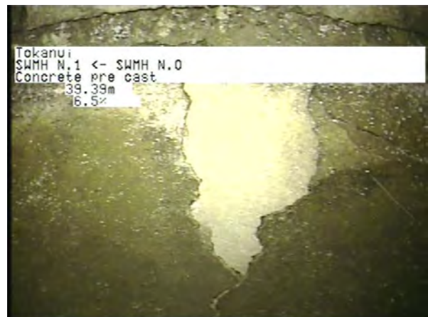
MH N.0 To MH N.1_f2864fbd-5ed4-43ba-949d-37f8b8cb9dbd_20230406_160238_511.jpg, 00:10:07, 39.39m
