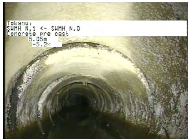
MH N.0 To MH N.1_ac7cb133-4512-45c0-a01b-6bd7c186c8b3_20230406_155218_080.jpg, 00:01:40, 5.05m
