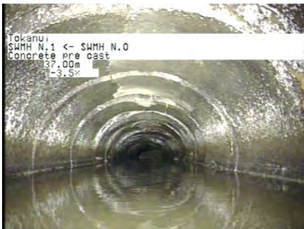
MH N.0 To MH N.1_b35e9991-e497-44ad-afd6-10aac7df1d05_20230406_160131_447.jpg, 00:09:07, 37.00m
