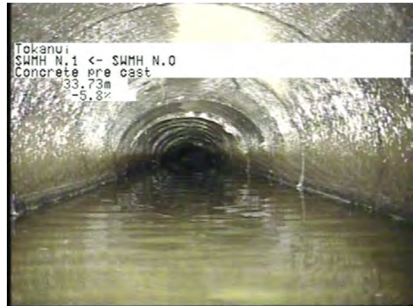
MH N.0 To MH N.1_8411798e-72cc-457d-aa6f-8cf4f8be5c3e_20230406_160056_090.jpg, 00:08:41, 33.73m
