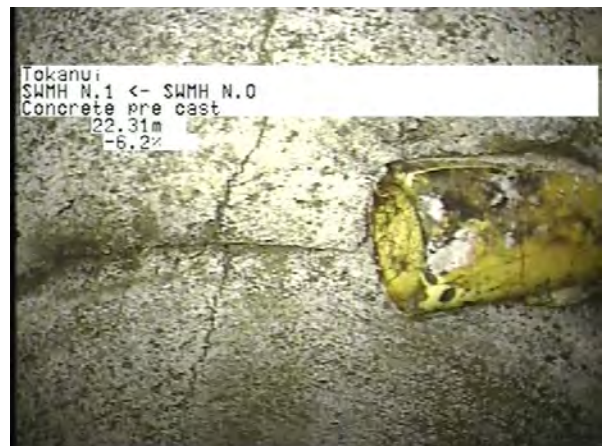
MH N.0 To MH N.1_33e4370a-b819-4c5e-9fc3-591f345c4d96_20230406_155748_522.jpg, 00:06:08, 22.31m
