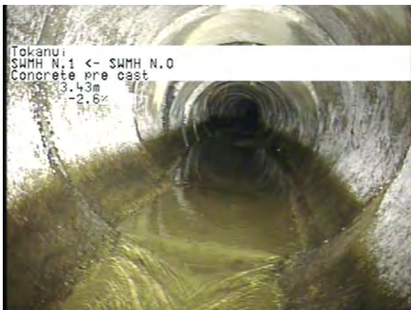
MH N.0 To MH N.1_221eed31-167c-4f08-826e-db48a05f480a_20230406_155157_256.jpg, 00:01:25, 3.43m
