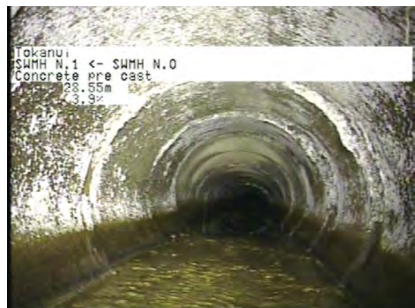
MH N.0 To MH N.1_d975649e-4ba4-4fbc-9259-76ecd8d5261e_20230406_155927_210.jpg, 00:07:27, 28.55m
