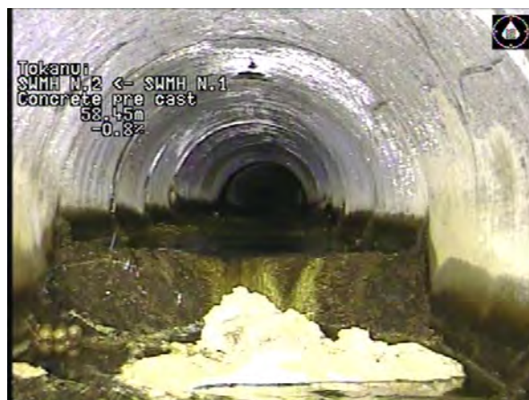
MH N.1 To MH N.2_d399f190-451f-4809-bac6-876092910497_20230424_10 0440_532.jpg, 00:16:10, 58.45m
