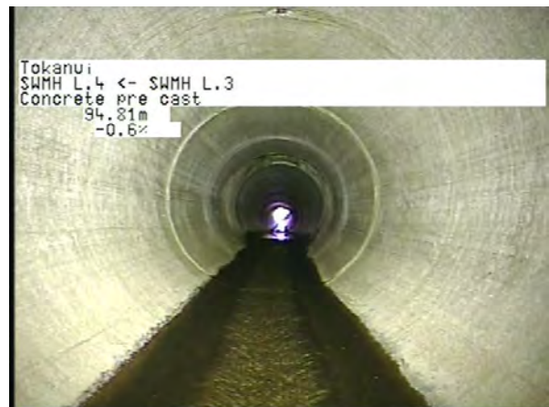
MH L.3 To MH L.4_f6360997-c065-4c52-9205-3b60b91c3178_20230404_09 5435_038.jpg, 00:23:02, 94.81m
