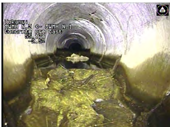
MH N.1 To MH N.2_c59d25d8-64b4-491b-9dcb-9b197f4d4d8b_20230424_10 0225_951.jpg, 00:14:32, 55.17m
