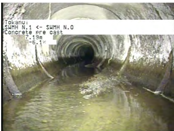
MH N.0 To MH N.1_c7232d6d-8ca5-4339-b763-ab7e100d83d2_20230406_155248_798.jpg, 00:01:59, 7.19m
