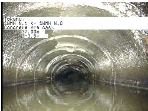
MH N.0 To MH N.1_b35e9991-e497-44ad-afd6-10aac7df1d05_20230406_160131_447.jpg, 00:09:07, 37.00m
