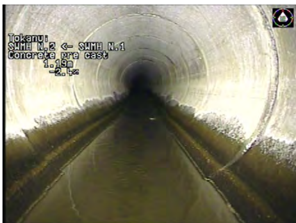
MH N.1 To MH N.2_9edf6547-a75e-42dc-a5a2-5c82b3edac54_20230424_09 4747_653.jpg, 00:00:59, 1.19m
