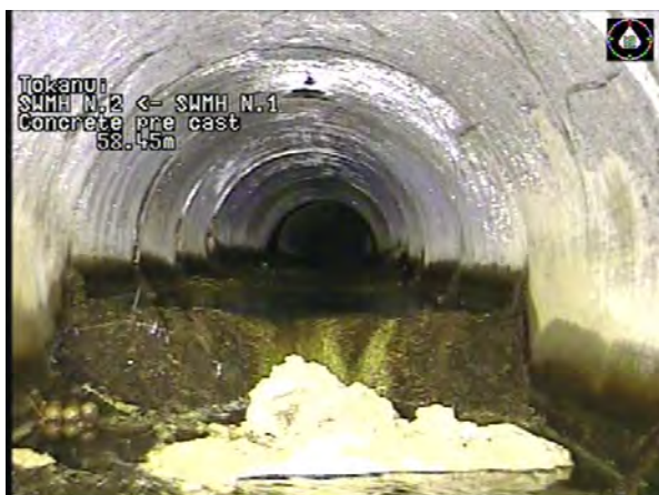
MH N.1 To MH N.2_b8ee1645-0d80-4422-b222-ed19e8726faa_20230424_10 0422_729.jpg, 00:16:05, 58.45m
