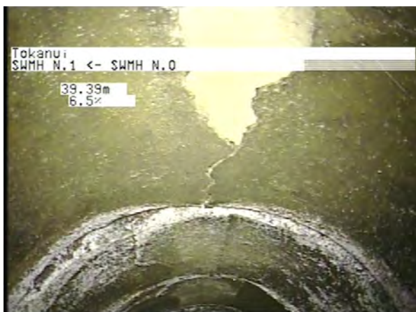
MH N.0 To MH N.1_f9fb307b-237d-47c4-a331-6183db07786c_20230406_160245_276.jpg, 00:10:07, 39.39m
