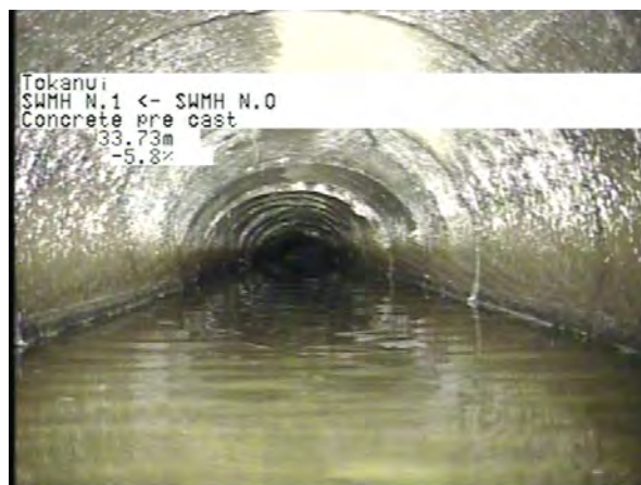
MH N.0 To MH N.1_8411798e-72cc-457d-aa6f-8cf4f8be5c3e_20230406_160056_090.jpg, 00:08:41, 33.73m
