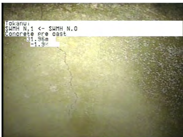
MH N.0 To MH N.1_30d3853e-2439-4199-8db5-d60147d27aa8_20230406_160002_120.jpg, 00:07:54, 31.96m
