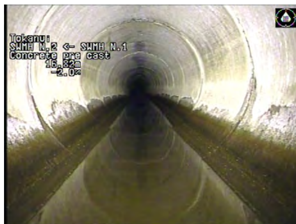
MH N.1 To MH N.2_f7bf921f-eb2b-42e4-9436-32cb18c6aa52_20230424_095 111_092.jpg, 00:04:16, 16.82m
