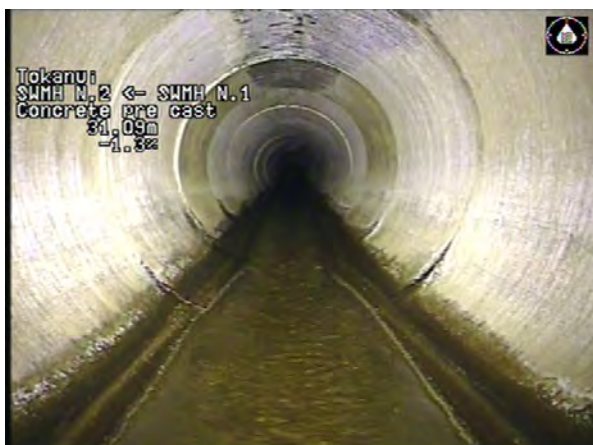
MH N.1 To MH N.2_c63ee5a0-3c23-4d9f-844f-a11509564c3e_20230424_095 446_091.jpg, 00:07:43, 31.09m
