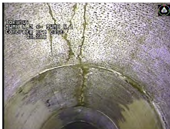
MH N.1 To MH N.2_5871115d-83dd-4e24-b180-30adad29c29d_20230424_1 00033_719.jpg, 00:12:48, 48.81m
