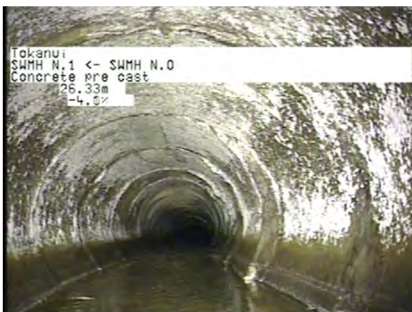
MH N.0 To MH N.1_e287cf9b-b63c-4d09-9c9e-0598a1d7223b_20230406_15 5906_831.jpg, 00:07:12, 26.33m
