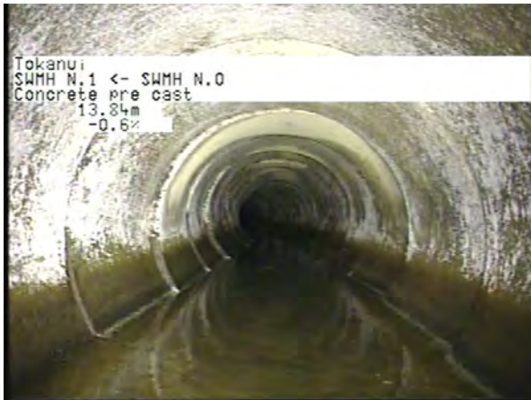
MH N.0 To MH N.1_2457edcf-bf72-4670-a094-92838979a6aa_20230406_15 5507_840.jpg, 00:03:58, 13.84m
