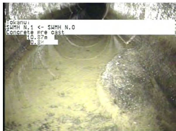
MH N.0 To MH N.1_11209ceb-76f4-48d7-87bc-2711dad56384_20230406_155403_423.jpg, 00:03:01, 10.87m
