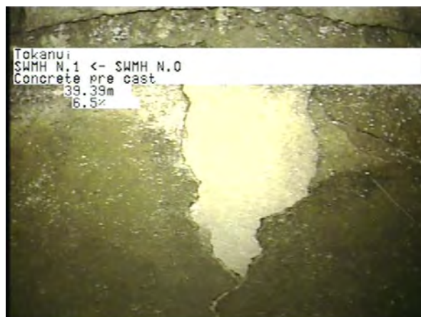
MH N.0 To MH N.1_f2864fbd-5ed4-43ba-949d-37f8b8cb9dbd_20230406_160238_511.jpg, 00:10:07, 39.39m
