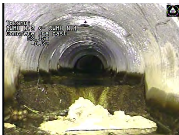
MH N.1 To MH N.2_a55ae409-c745-4899-89f7-bbce7466703d_20230424_10 0412_241.jpg, 00:16:04, 58.45m
