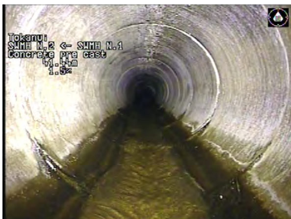
MH N.1 To MH N.2_86ad3450-3e9e-4312-abf6-b71885a288ad_20230424_09 5844_517.jpg, 00:11:24, 41.44m
